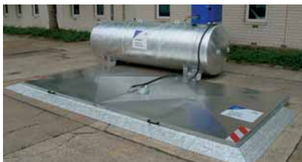
Die geschlossene Eigenverbrauchs-Tankanlage (Außenaufstellung)
