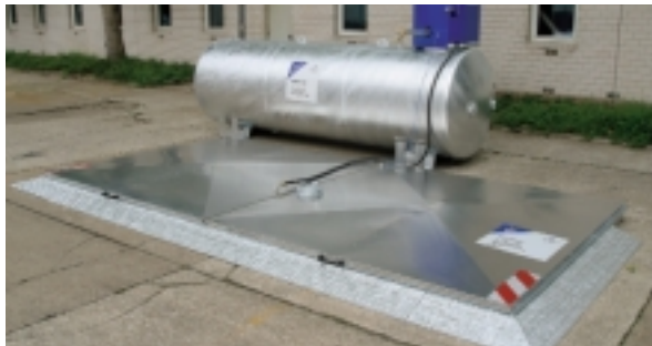
Die geschlossene Eigenverbrauchs-Tankanlage
