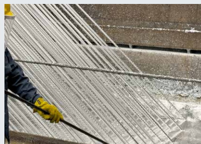
Zink schützt dauerhaft vor Betonkorrosion
