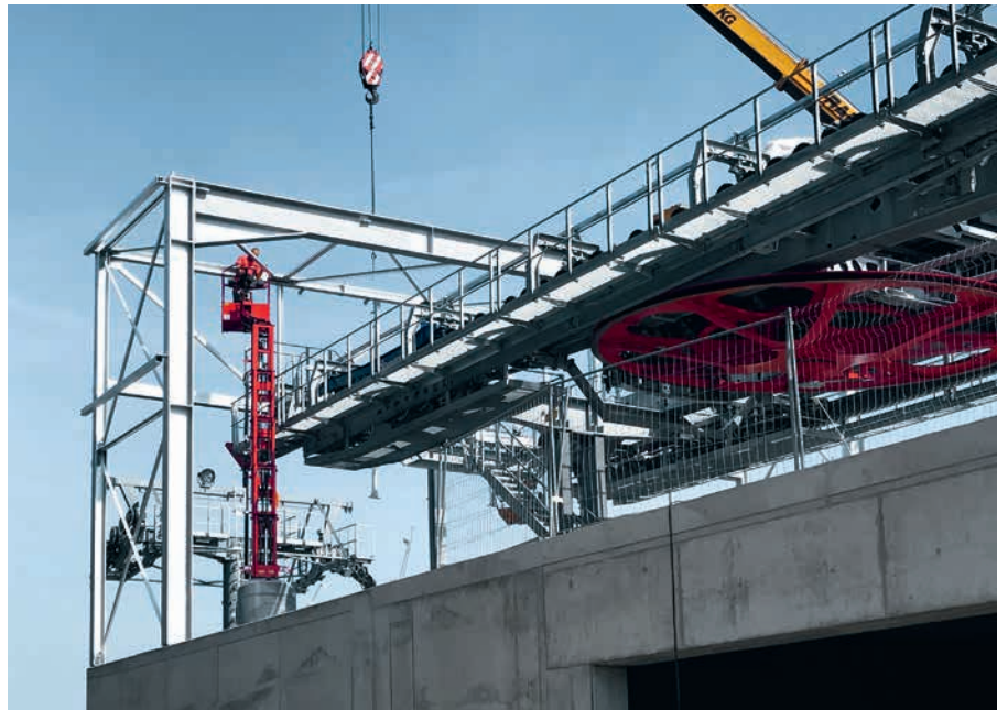
^ Montage der verzinkten Stahlträger an der Bergstation des 8er-Sessellifts.
