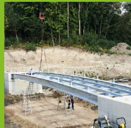
^ Vorher – nachher: die Brücke im „Rohzustand“ (Bild oben) und die fertige Anlage mit den von uns verzinkten Stahlträgern (Bild unten links).
